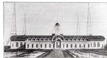
FACADE PRINCIPALE DE LA STATION RADIOÉLECTRIQUE LA FAYETTE A CROIX D'HINS
